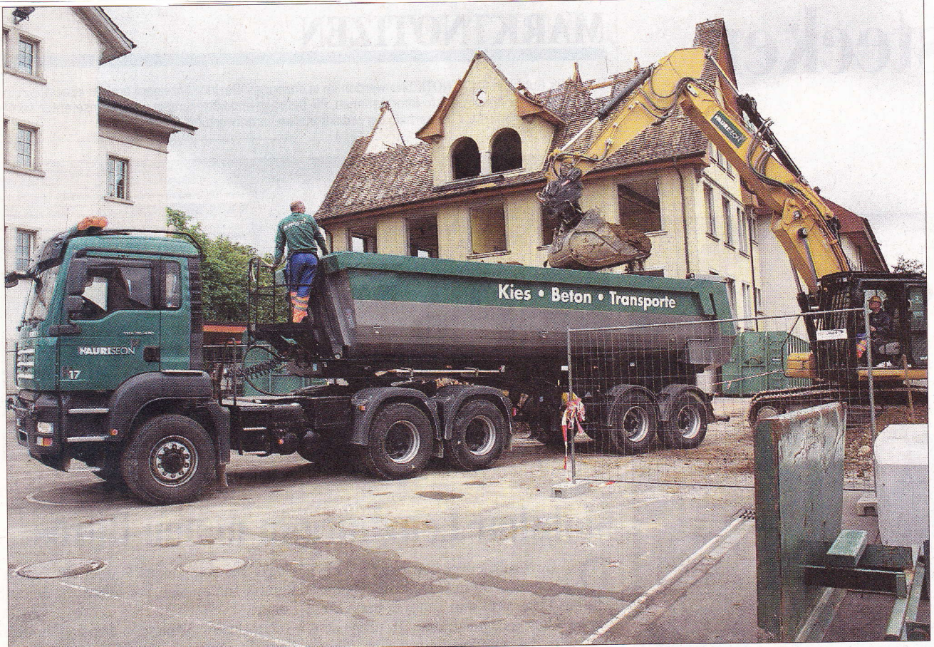
Am Montag haben die Bauarbeiten zur Sanierung der Schulanlage Seengen begonnen.
